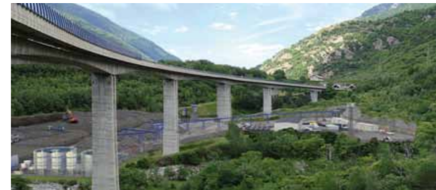
Vue du chantier de la galerie de reconnaissance en phase d'excavation et de mise en dépôt des déblais
